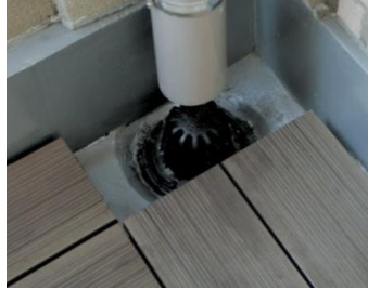
カットして雨樋・排水口まわりを確保。
